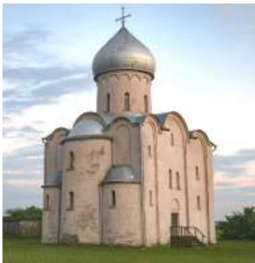
Рис. 2. Церковь Спаса на Нередице близ Новгорода. 1198. Вид после реставрации
