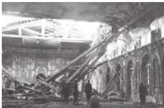
Рис. 3. Царское Село (г. Пушкин). Большой зал Екатерининского дворца. Середина XVIII в. Разрушения. Фото 1944 г.
